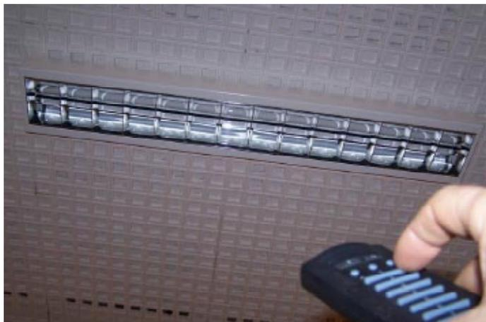
F29: Lichtenanlage schalten mit Funkbussystem, EIN / AUS
