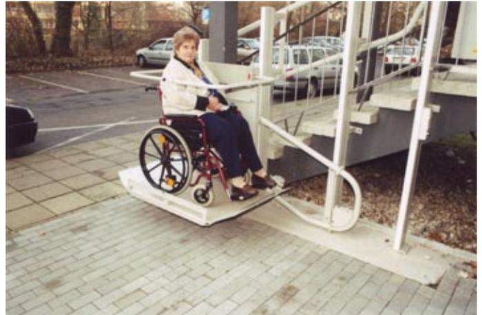
Neben dem Plattformlift gibt es als weitere Möglichkeiten die technische Lösung über eine Hebebühne für Personenbeförderung mit einer maximale Förderhöhe bis ca. FH = 1,60 m. Dieser Fall ist preiswerter als die Aufzugsvariante. Bei einer genügend großen Personenplattform am Haupteingang des Hauses kann diese Hebebühne senkrecht neben den Treppenlauf installiert werden.
